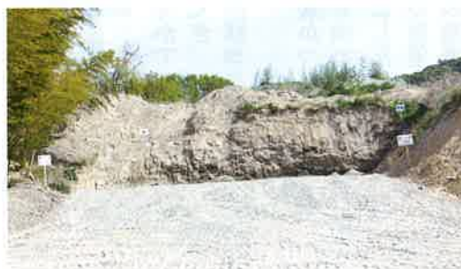
新しくなった汚泥等仮置場
